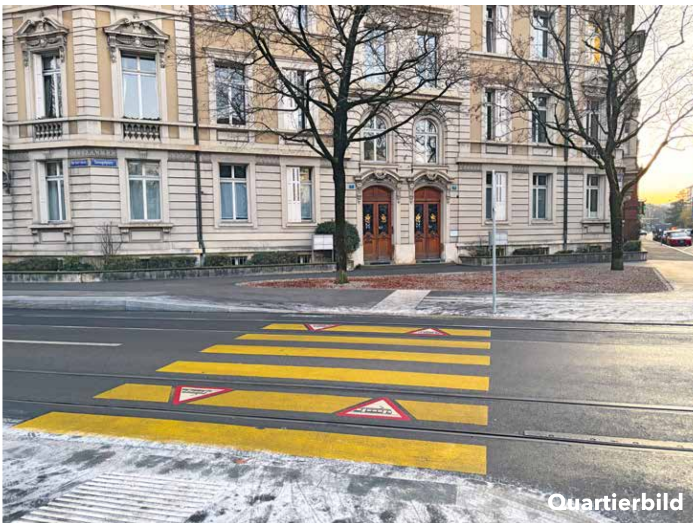
Behindertengerecht? Sehbehinderte erkennen die Signalisierung auf dem neuen Fussgängerstreifen am Sevogelplatz kaum und laufen deshalb Gefahr. Riskant ist der Übergang auch für jene, die den früheren Standort der Tramhaltestelle (stadtauswärts) kannten. Foto: Olivia Kalantzis
