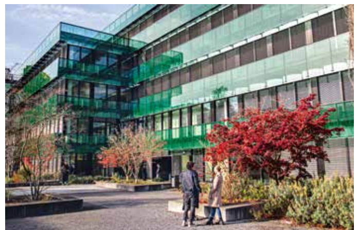
Der neue Sekundarschulstandort an der Gartenstrasse bietet Platz für bis zu 18 Klassen. Foto: z.V.g. Kanton Basel-Stadt
