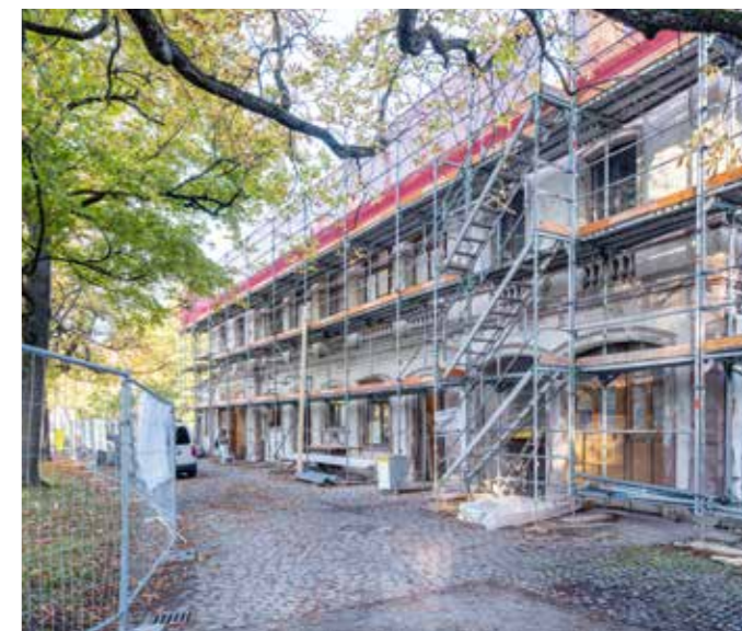
Beim Gärtnerhaus im Schwarzpark laufen die Sanierungsarbeiten auf Hochtouren. Foto: Walter Hiltbold
