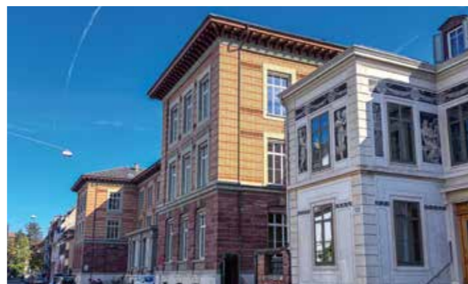
Das Sevogelschulhaus 2024: ein Sockel aus hellem Kalkstein, ein Erdgeschoss in rotem Sandstein, unterschiedlich helle Bänder roten Backsteins, Fensterrahmen und Simse aus grünlichem Sandstein. Foto: WK
